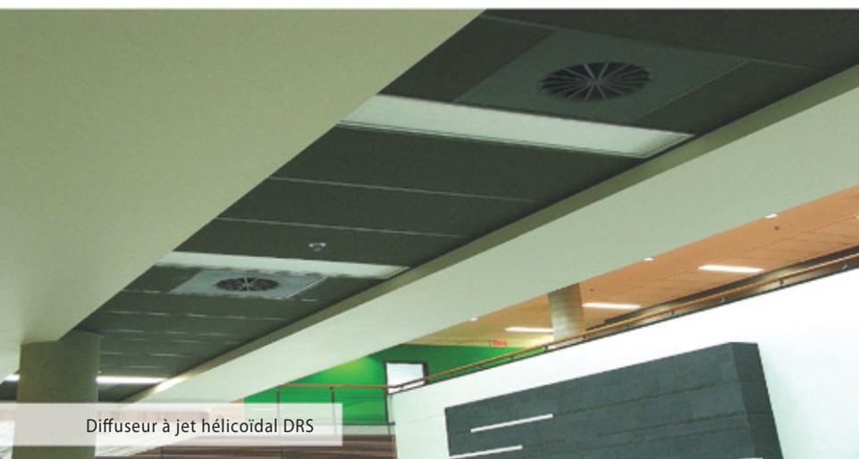
Diffuseur à jet hélicoïdal DRS
